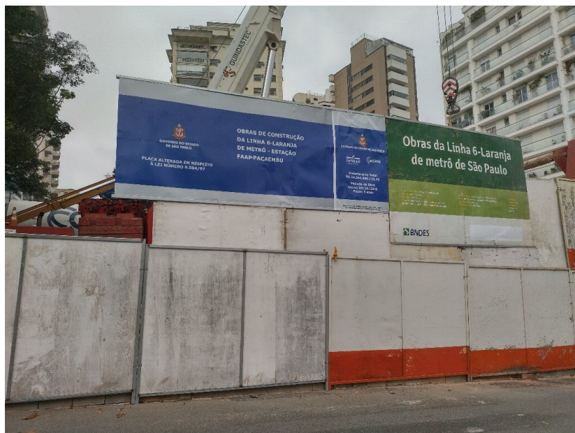
Figura 3 - Tapume de obra (Fonte: Wikimedia Commons, 2022. Disponível em: https://commons.wikimedia.org/wiki/File:Esta%C3%A7%C3%A3o_FAAP-Pacaembu_Linha_6_Laranja_Metr%C3%B4_de_S%C3%A3o_Paulo_%E2%80%A2_constru%C3%A7%C3%A3o_em_julho_2022_%E2%80%A2_8.jpg , acesso em 6 mai. 2026)
