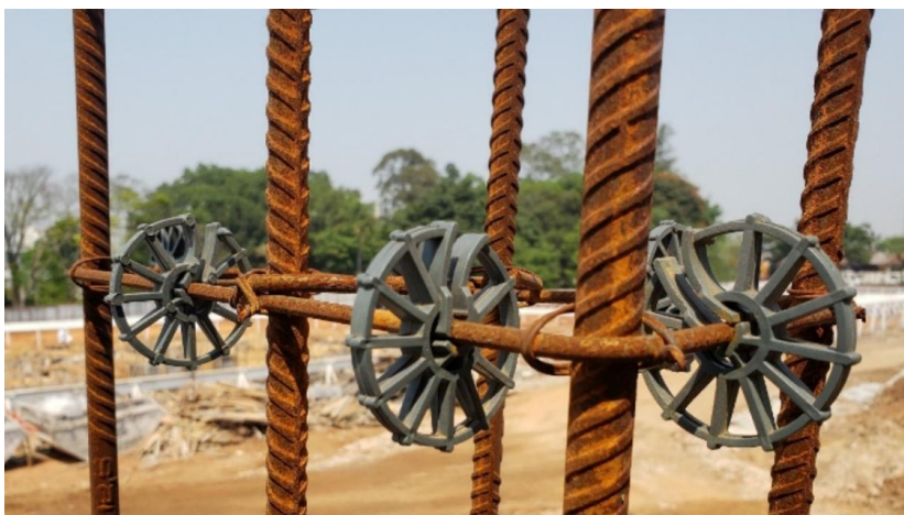
Figura 11 – Espaçadores de concreto (fonte: COPLAS, 2026, disponível em: https://coplas.com.br/category/espacadores-plasticos/ , acesso em 6 mai 2026).
