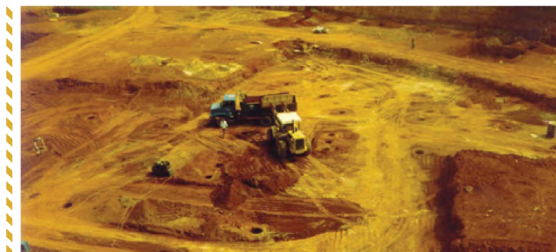
Figura 5 - Vista da execução da terraplenagem de uma futura instituição pública
