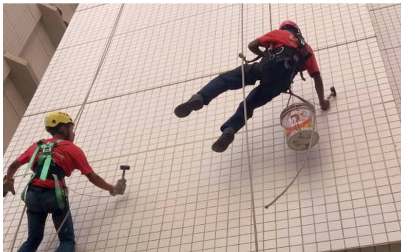
Figura 17 – Ensaio de percussão (“som cavo”) em revestimento cerâmico. Fonte: Oicram Engenharia, 2026. Disponível em: https://oicramengenharia.com.br/teste-de-percussao-em-fachadas/ , acesso em 6 mai. 2026)
