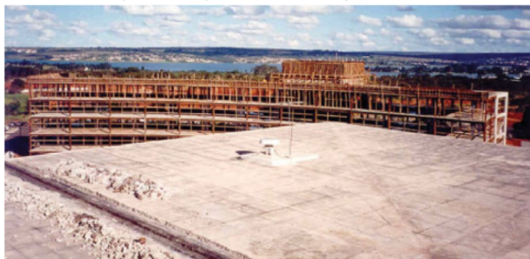
Figura 16 – Detalhe da cobertura de uma construção
