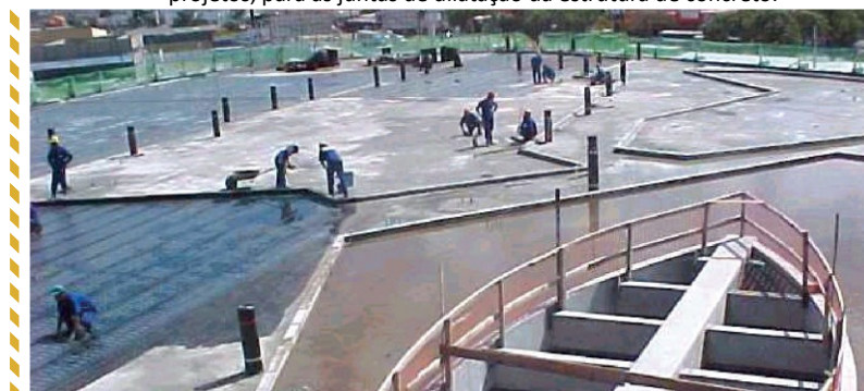
Figura 18 – Cobertura de edifício. Impermeabilização da laje para instalação de espelhos d'água e jardins
