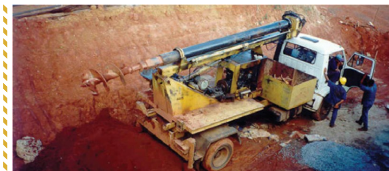
Figura 9 – Perfuração de solo para a execução de uma estaca de fundação
