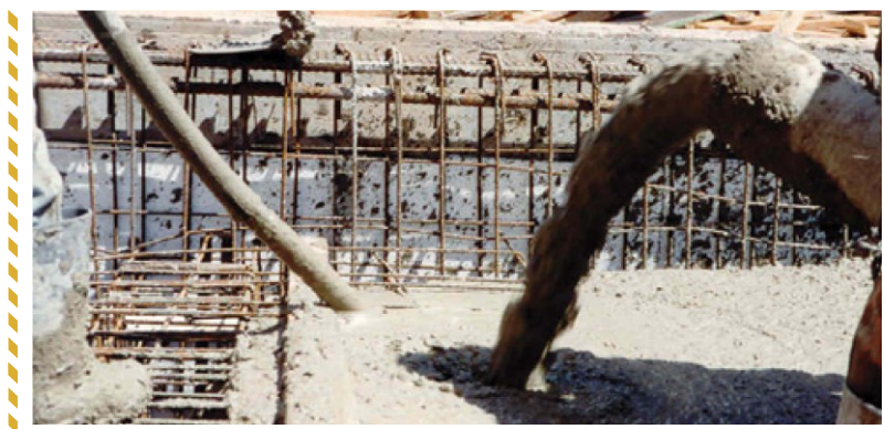
Figura 12 – Concretagem de uma laje e suas respectivas vigas
