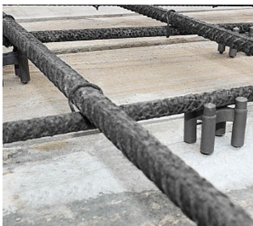
Figura 12 – Espaçadores de concreto (fonte: MOLDIMPLAS, 2026, disponível em: https://moldimplas.com.br/produtos/espacadores-de-concreto , acesso em 6 mai 2026).
